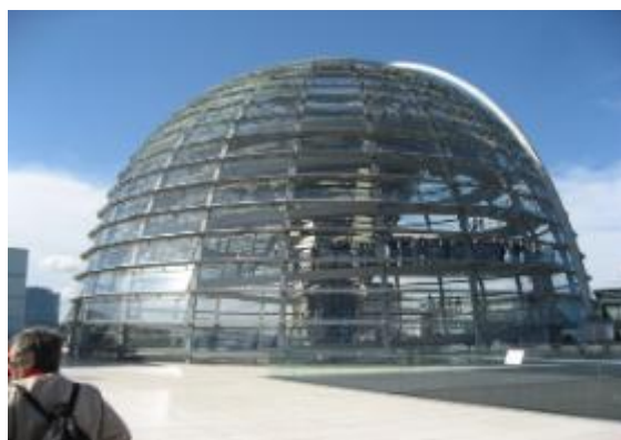
La Coupole reconstruite du Reichstag
